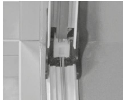
BLOCCHETTO DI REGOLAZIONE TENSIONAMENTO FILI DI SOSTEGNO RETE PLISSETTATA
