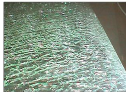
c) rottura di una lastra stratificata di sicurezza
