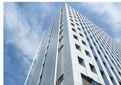
facciata ventilata nuova sede della Provincia di Torino
