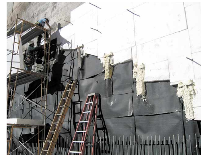
isolamento parete esterna
