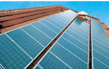
impianto fotovoltaico parzialmente integrato
